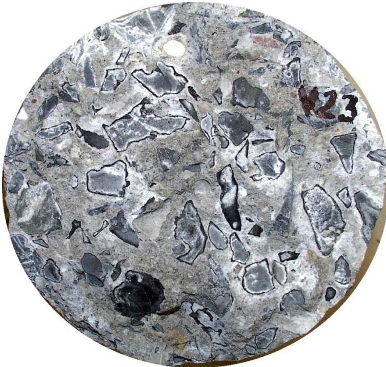
Čerstvá lomová plocha vývrtu z CB krytu D11 (průměr 150 mm)
